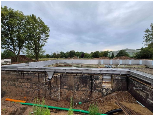
Wasserzuleitung vom und zum Technikraum:
