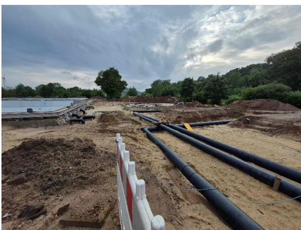
Wasserzuleitung vom und zum Technikraum:
